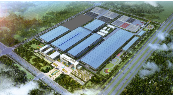
◆ 旗下东风奕派汽车科技公司襄阳工厂光伏建设
